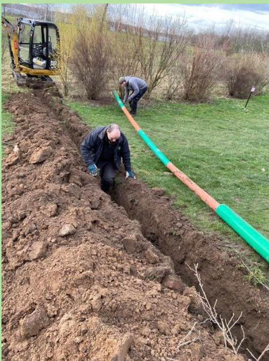
Die Beregnungsanlage wird erweitert
